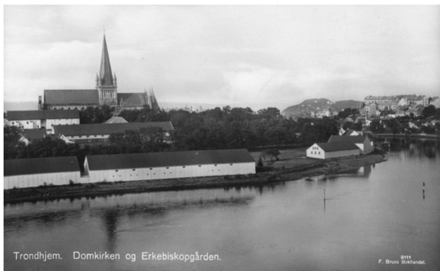
Utsyn mot Marinen med Erkebispegården og Nidarosdomen i bakgrunnen. I forgrunnen ser man de militære depotbygningene som Dedekam ønsket å fjerne for å anlegge museumsområde og folkepark. Foto: Ukjent fotograf. Domkirken (Før 1930). Tilhører NTNU Universitetsbiblioteket.
